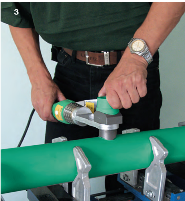
3 Assicurarsi che il polifusore e le matrici a sella abbiano raggiunto la temperatura di esercizio ( 260^{\circ} \pm 10^{\circ} \text{C} ) La parte concava della matrice deve essere inserita nel foro praticato nella tubazione fino al raggiungimento della parete esterna del tubo. Contemporaneamente inserire il raccordo nella parte convessa della matrice. Il tempo di riscaldamento è di 12 secondi per tutti i diametri.
