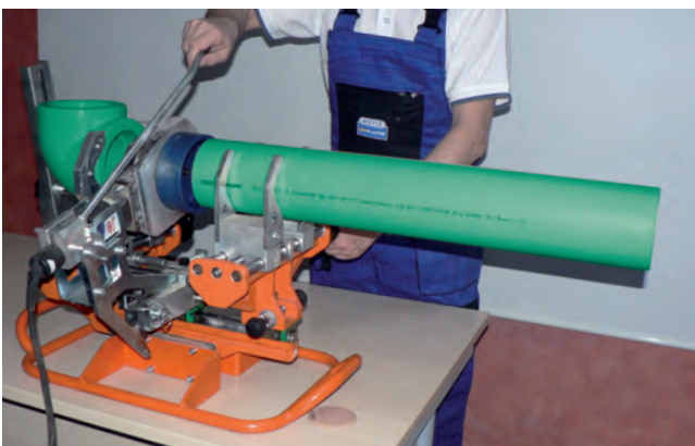
Fissaggio e allineamento dei componenti tra le ganasce della saldatrice e procedere con la fase di riscaldamento
